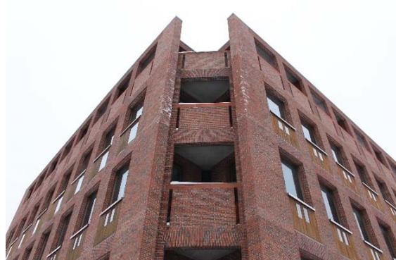
**FIG 20 e 21** | O volume composto por quatro blocos independentes de alvenaria [fotos do autor]
